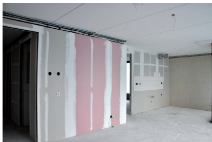
Metalstudwand met BoWall, achteraf installeren.
