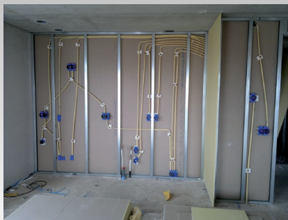
Metalstudwand traditioneel, vooraf installeren.
