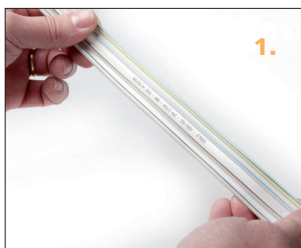
Kies de positie van de aftakking op de bandkabel.
